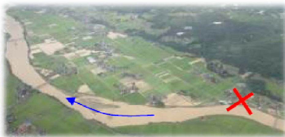
▲五十嵐川の破堤地点(三条市江口地内)
