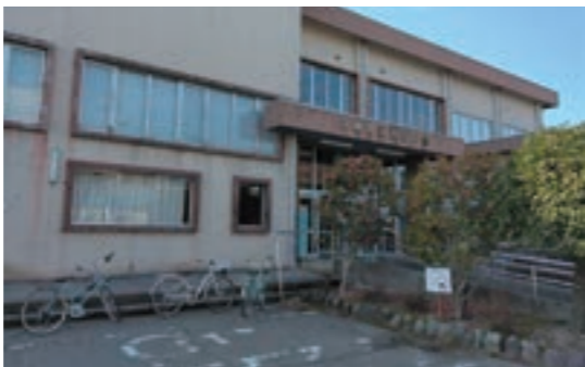
取り壊される嵐南公民館
