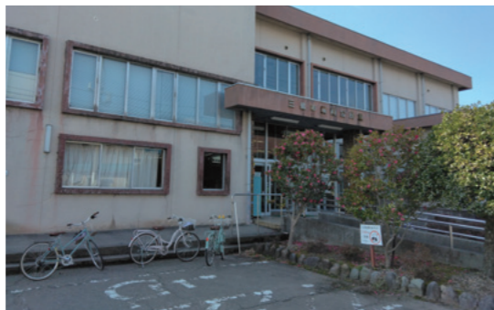
取り壊される嵐南公民館
