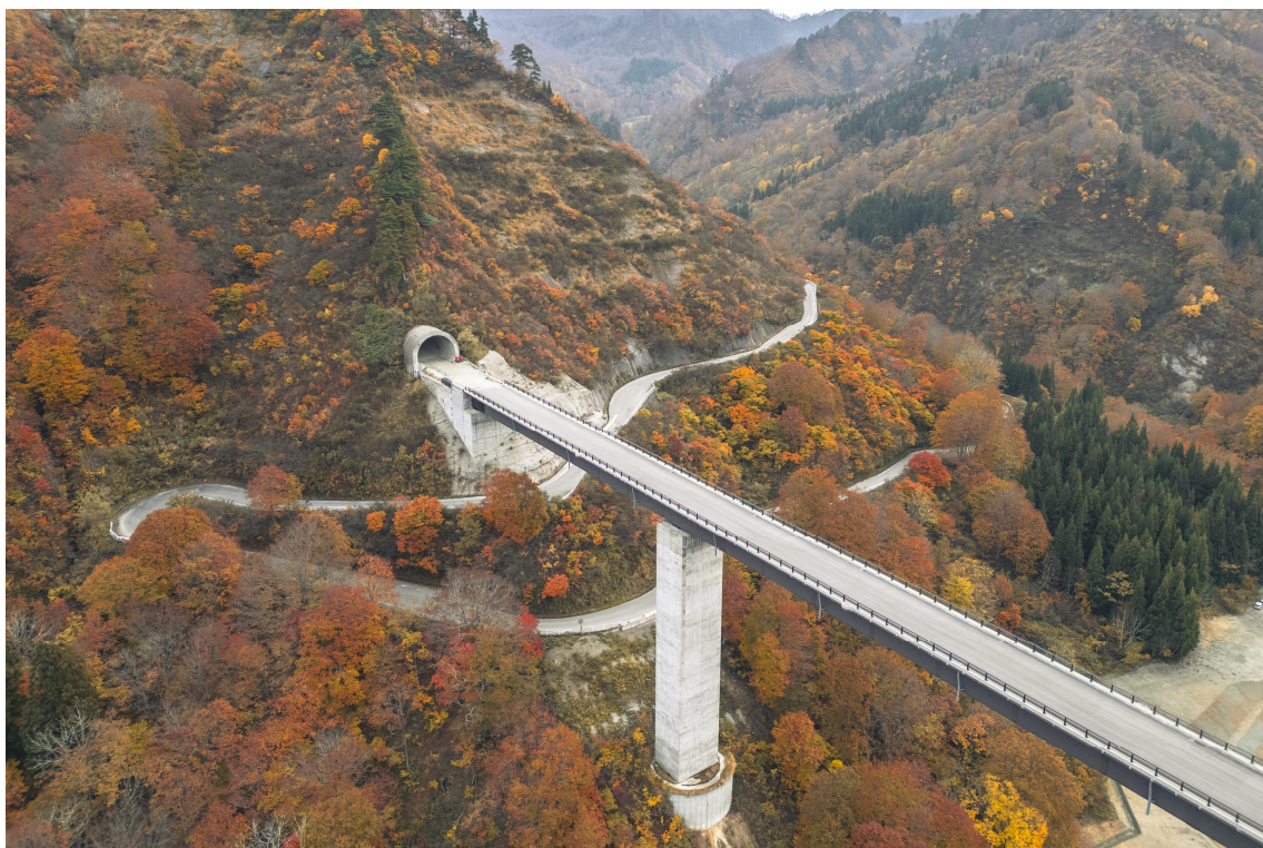
新潟・福島県境で工事が進む国道289号「八十里越」
