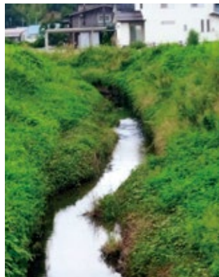
土砂の堆積が進む大面川（北潟地内）
