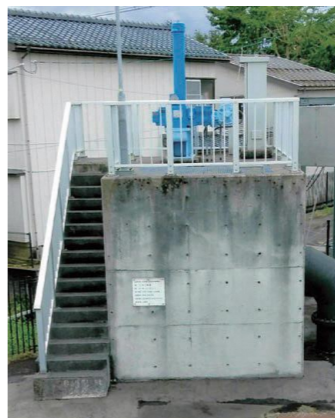
曲淵二丁目ポンプ場のピット
