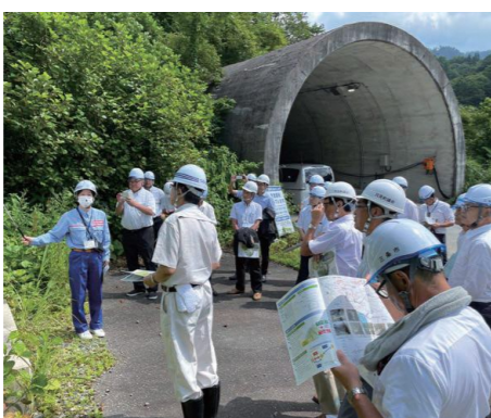
県境部の工事説明会
