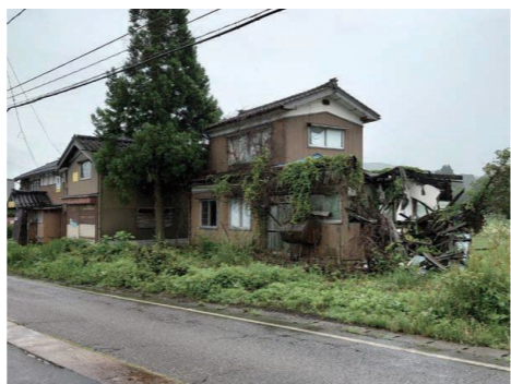
「危険がない？」 放置家屋
