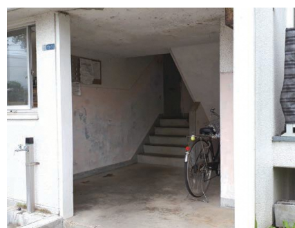
公営住宅入口 1階でも階段がある
