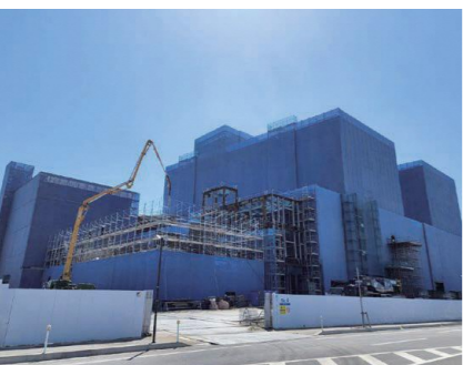
令和6年3月の開院に向け工事が進む済生会新潟県中央基幹病院
