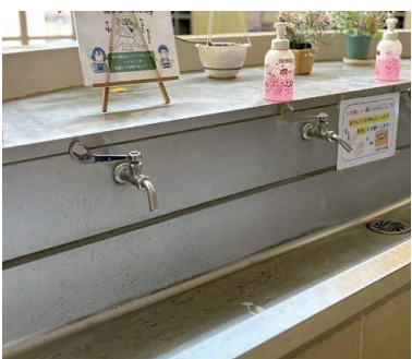
栄中学校の手洗い場
