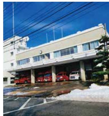
築50年が経過した消防本部庁舎
