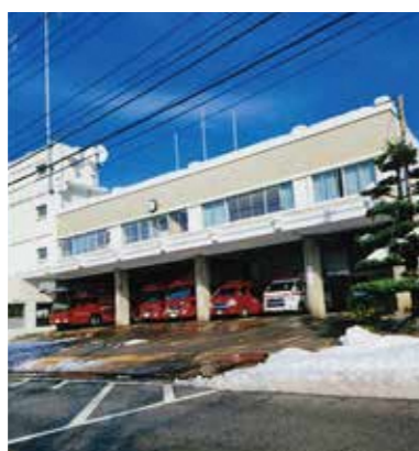
築50年が経過した消防本部庁舎
