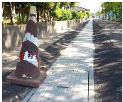
県央工業高校脇排水路工事
