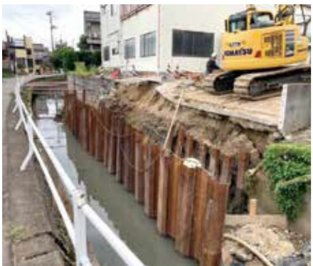
鳥田川未改修部の崩れた護岸の緊急工事
