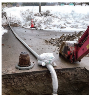
運場地内水道管の漏水復旧工事
