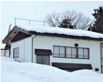
命綱固定アンカー設置の状況
