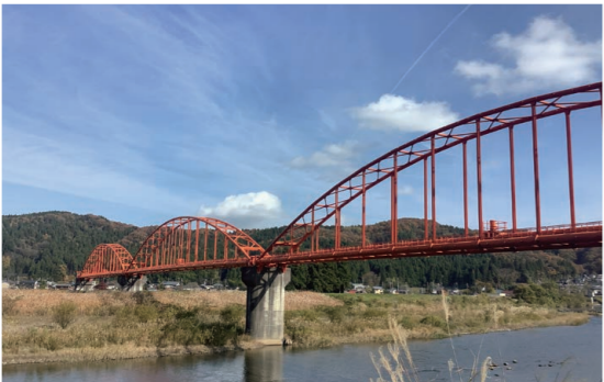
水管橋7号橋（箆場）
