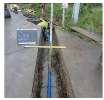
県の道路改良工事に伴う移設補償工事
