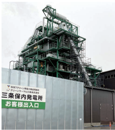
稼働中の木質バイオマス発電所
