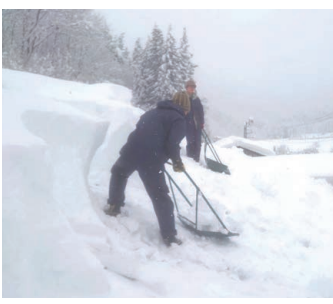
屋根の雪下ろし作業
