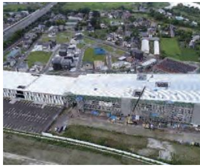
感染症拡大の影響もなく、順調に建設工事が進む来春開学予定の三条市立大学
