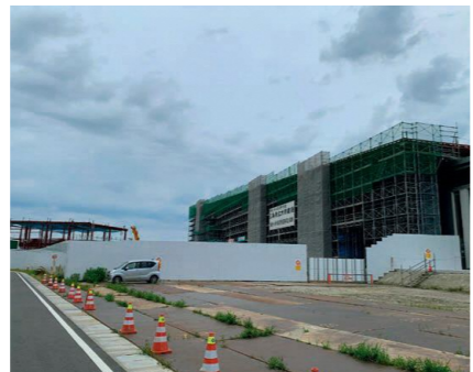
建設中の三条市立大学
