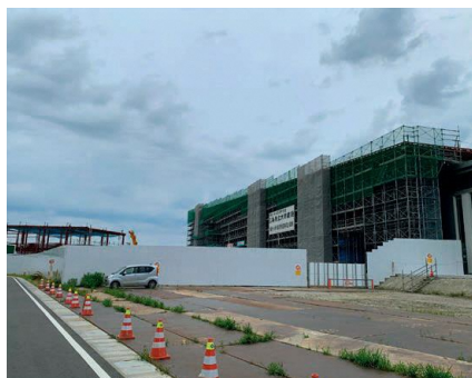
建設中の三条市立大学
