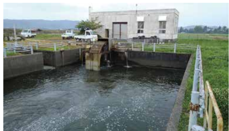
老朽化している農業用水の揚水機場
