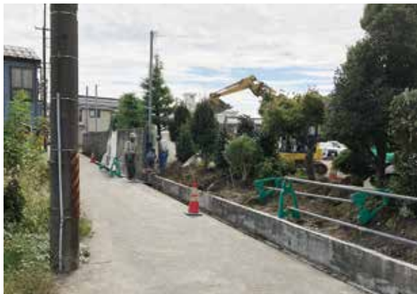
ブロック塀の撤去作業
