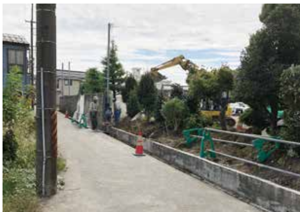
ブロック塀の撤去作業
