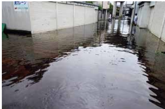
冠水した道路
