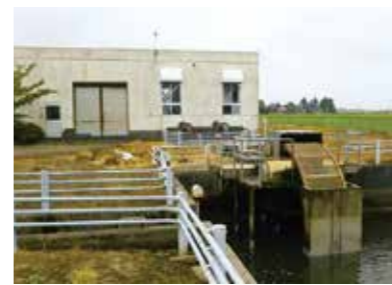
老朽化した揚水機場
