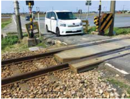
大崎地区と井栗地区を結ぶ牛ヶ島踏切
