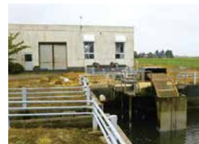
老朽化した揚水機場
