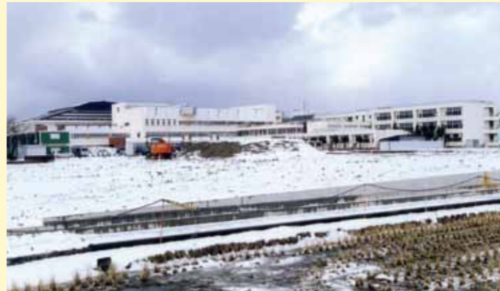
工事が進む大崎学園
