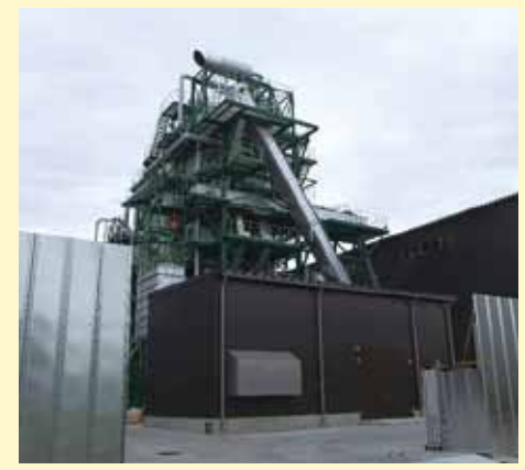
保内のバイオマス発電所
