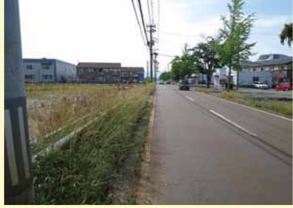
都市計画道路3・3・5 下須頃上須頃線の現況
