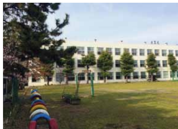
複合施設の建設が計画される旧三条小学校
