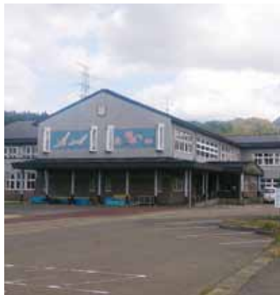
協力隊の活動拠点である旧荒沢小学校
