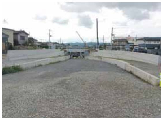
建設中の新保裏館線・信越本線アンダー工区
