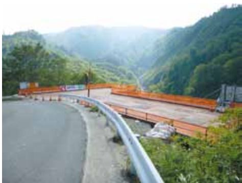
八十里越5号橋梁の工事用作業橋台
