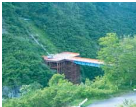
八十里越5号橋梁の工事用作業橋台
