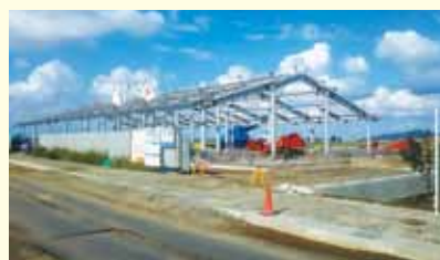
建設中の保内地区交流拠点施設
