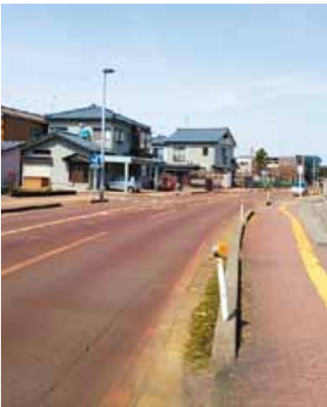
無電柱化されている道路
