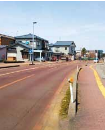
無電柱化されている道路
