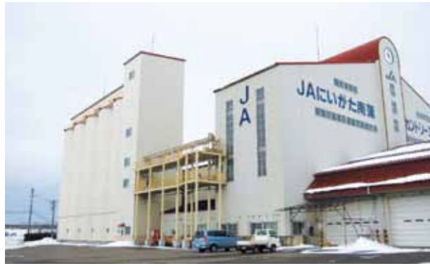
カントリーエレベーター
