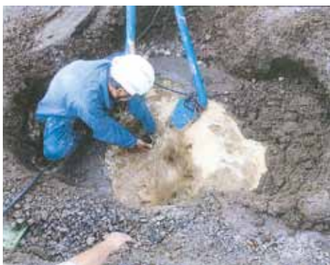
給水管の漏水修理
