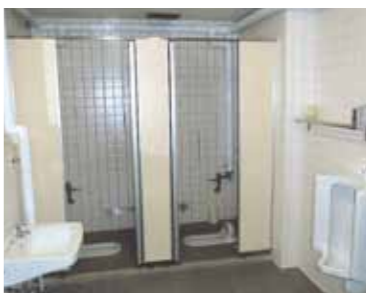
改善が必要な箇所
