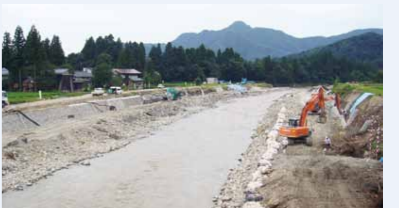
大名橋下流の工事現場
