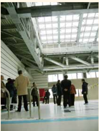
可動床プール
