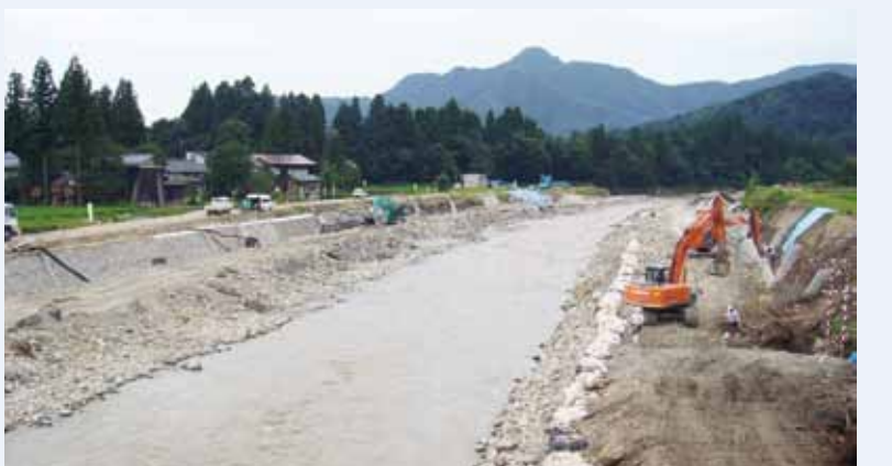
大名橋下流の工事現場
