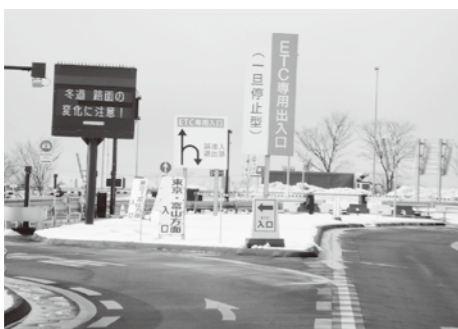
栄スマートインターチェンジ
