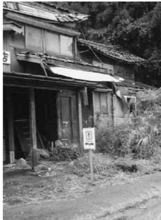
空き家となった家屋
