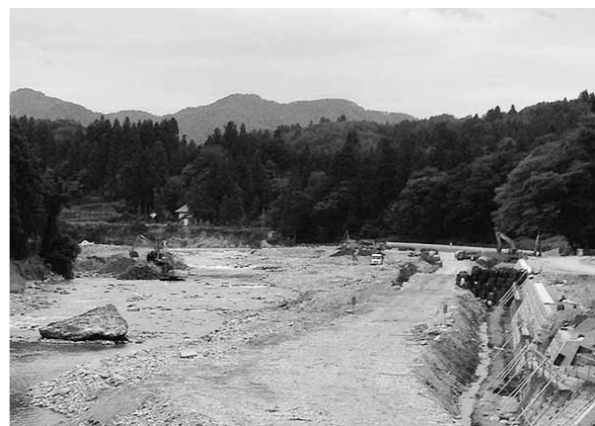
復旧中の災害現場(大名橋上流部)
