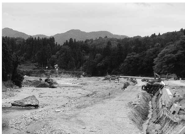
復旧中の災害現場（大名橋上流部）
