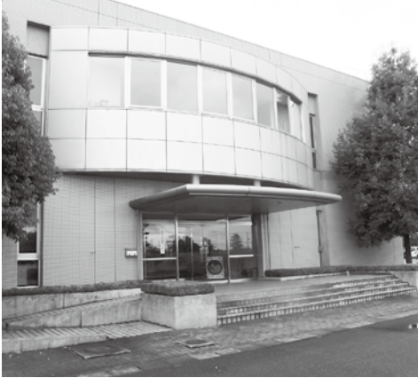
下水処理センター
