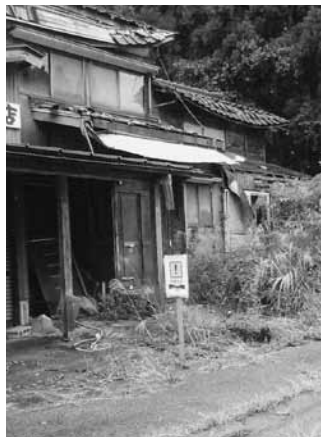
空き家となった家屋
