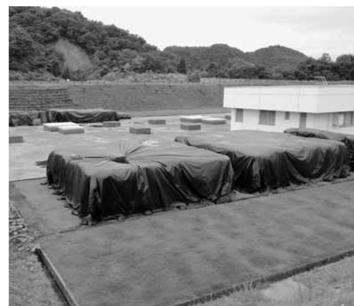
三条地域水道用供給企業団敷地内に保管される汚泥
