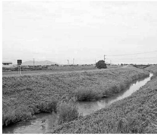
国道403号三条北バイパス第2工区と布施谷川架橋予定地
