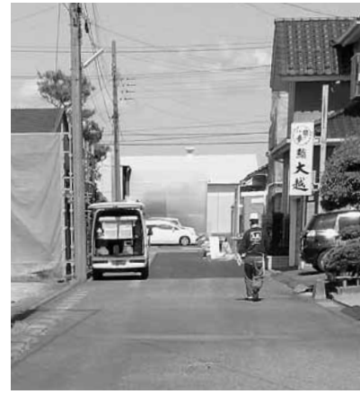
補修を待つ道路
