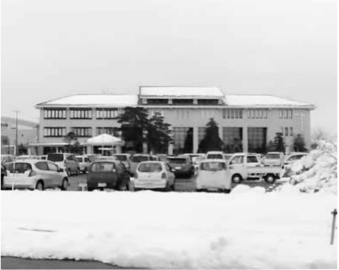
3階の利活用が検討されている栄庁舎
