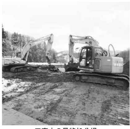
工事中の最終処分場
